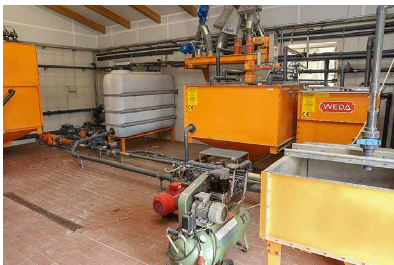
Die Nebenprodukte werden aus dem Vormischtank (links) in den mittig stehenden Hauptanmischtank eindosiert.
